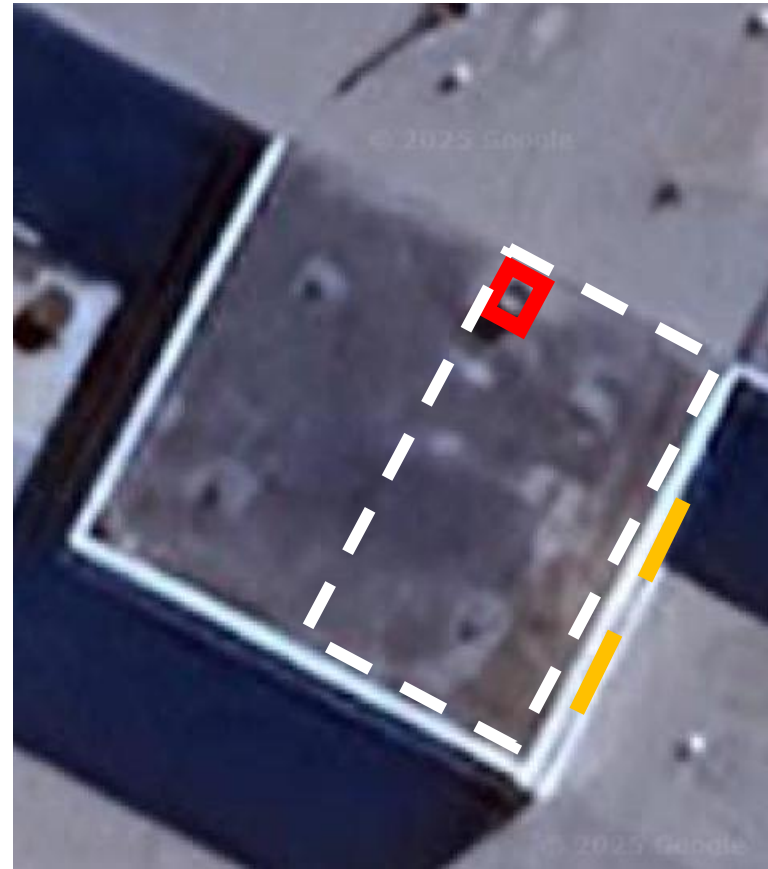
Subestación M3 (dentro del rayado)
