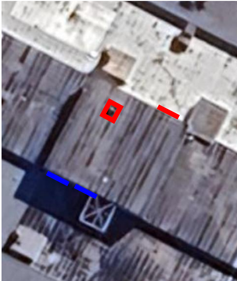
Subestación A Estampado (idem SE B)
