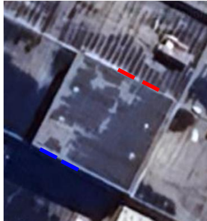
Subestación C Estampado
